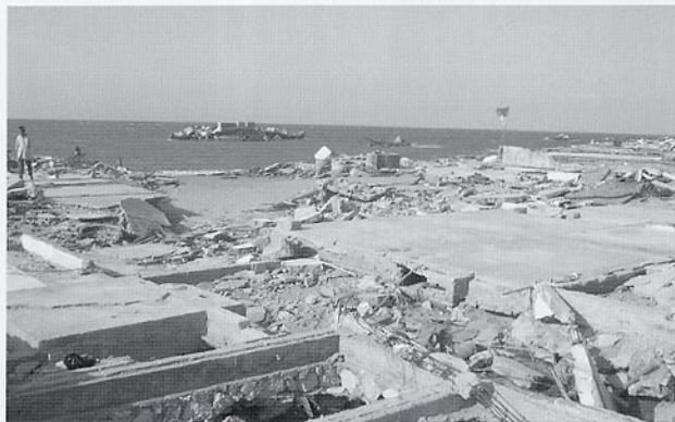
津波から1か月半後のウレレー海岸。右手前方に旗が立てられている
