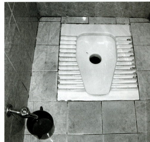
トルコ式トイレ。滑らないよう、足の踏み場がギザギザになっている。用を足した後、バケツの水で流す
