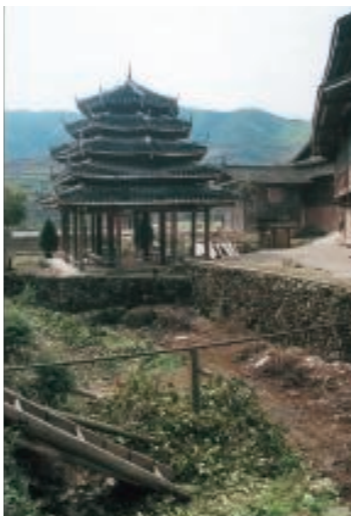
錦溪の湾曲地点に建つ新鼓楼
