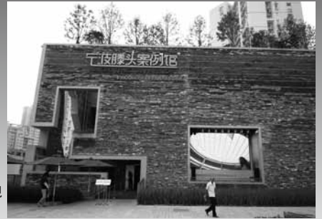
寧波滕頭実践例館の外観
