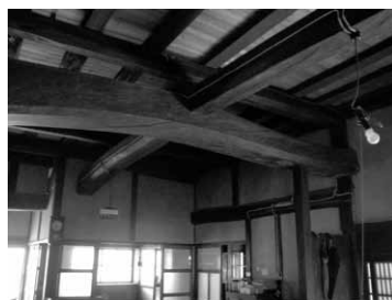
1階天井部分が2階の厨子（ツシ）部分にあたる
