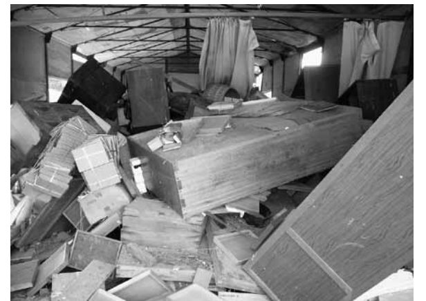
津波で壊滅的な被害を受けた文化財収蔵庫
