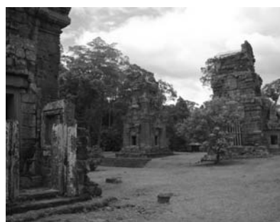
JASA (日本) によって修復されたプラサット・スープラ遺跡
