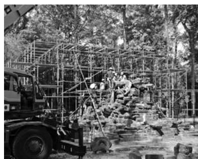
奈良文化財研究所による西トップ遺跡の修復
