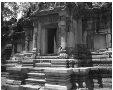
CSA (中国) によって修復されたチャウ・サイ・テポタ遺跡
