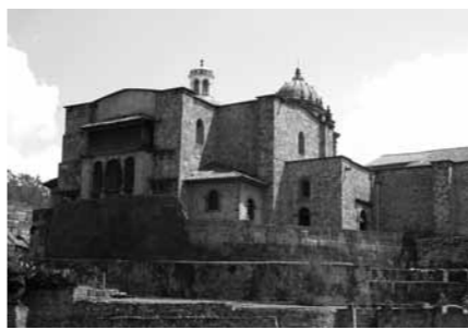
植民地時代に建設されたサント・ドミンゴ教会。建物はインカの太陽神殿の石組みの上に建てられている
