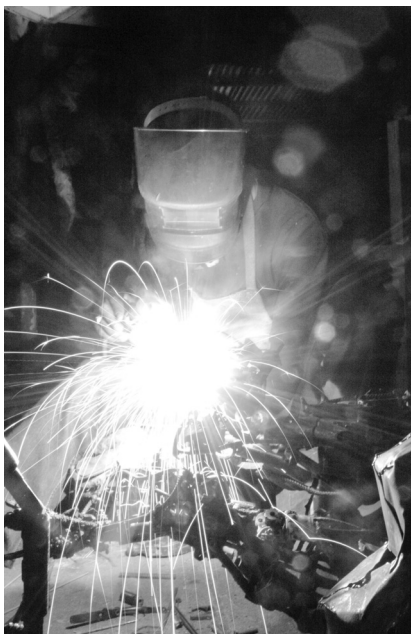
写真2 溶接作業。マプト市、CCMにて。2012年10月、吉田憲司撮影
