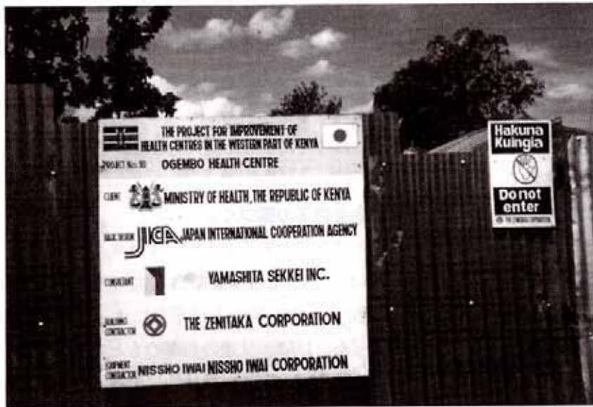
JICA支援で西ケニア・オゲンボ県に建設中のヘルスセンター，2002年
